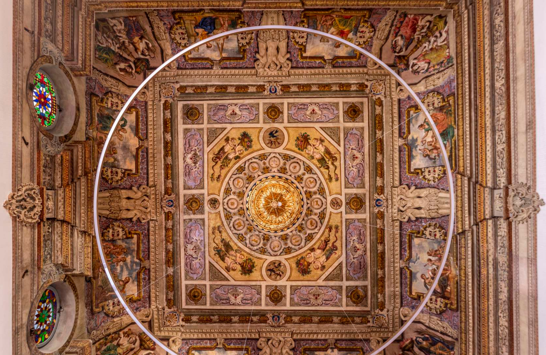
Sala Sant Mori La gran sala de baile de los Moxó y uno de los mayores tesoros del Palau
